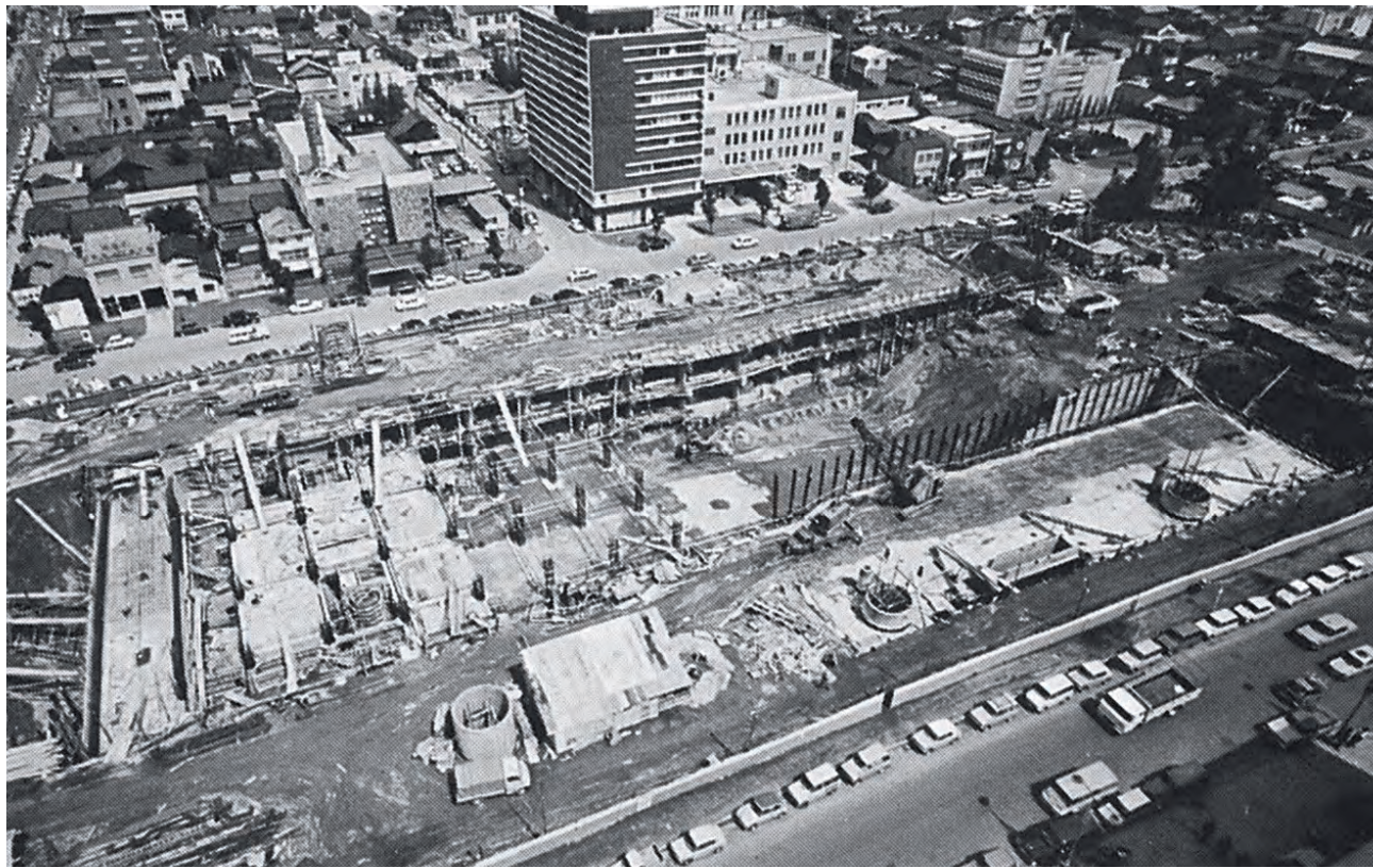
1966年(昭和41)5月 エンゼルパーク駐車場南館工事全景 地下鉄名城線の上と久屋大通公園の下を利用した当時珍しい地下2層構造
