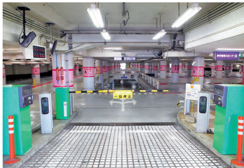
2013年（平成25）2月 エンゼルパーク駐車場南入口 DSRC（専用狭域通信）を用いた車両認識システム・バイク用発券システムなど新たな入出車管理システムを採用し、駐車料金精算システム機器をリニューアルしました
